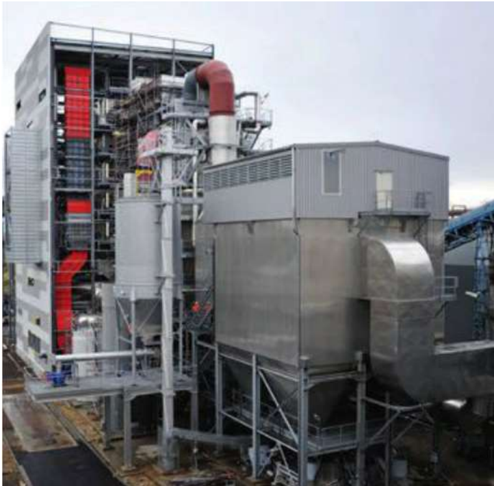
Centrale de cogénération à Metz. La station utilise la biomasse de déchets de bois comme source d'énergie et fournit de l'électricité et de la chaleur à 30 000 foyers.
