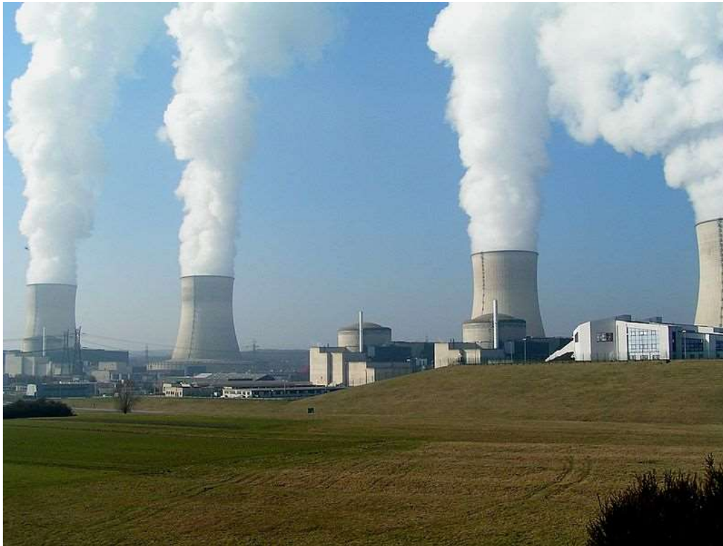
Central elétrica, em algum lugar de Alemanha.
